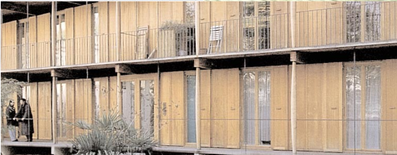
Architectonische ruimtes die tegelijk binnen en buiten zijn versterken de relatie met de landschapstuin.
